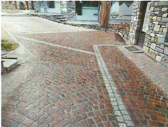
Rue devant le nouveau bureau de poste dédiée à la circulation, absence de stationnement
